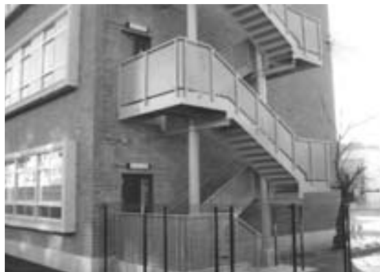
新しく設置された非常階段
