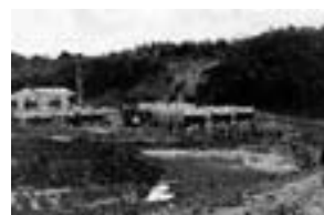
新校舎工事風景（昭和46年）
