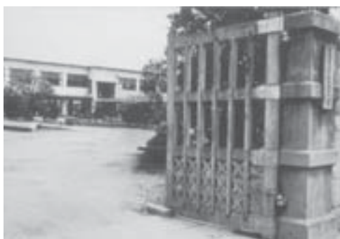
本館竣工当時の校門からの光景
