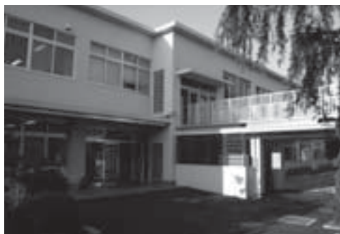
改修後の本館校舎（玄関付近）
