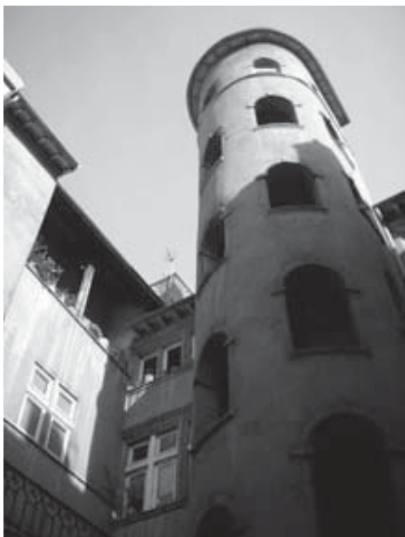
写真3 塔状になった階段室
